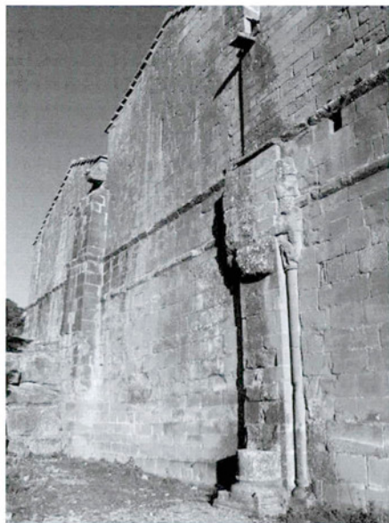
FIGURA 2: Detalle del muro occidental y del pilar empotrado en la iglesia de Santiago de Agüero
